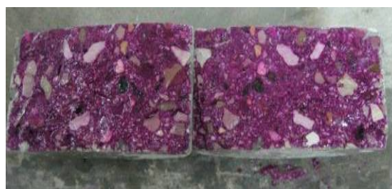
Fig. 136. Profundidad de carbonatación del H-0,50 50%.
