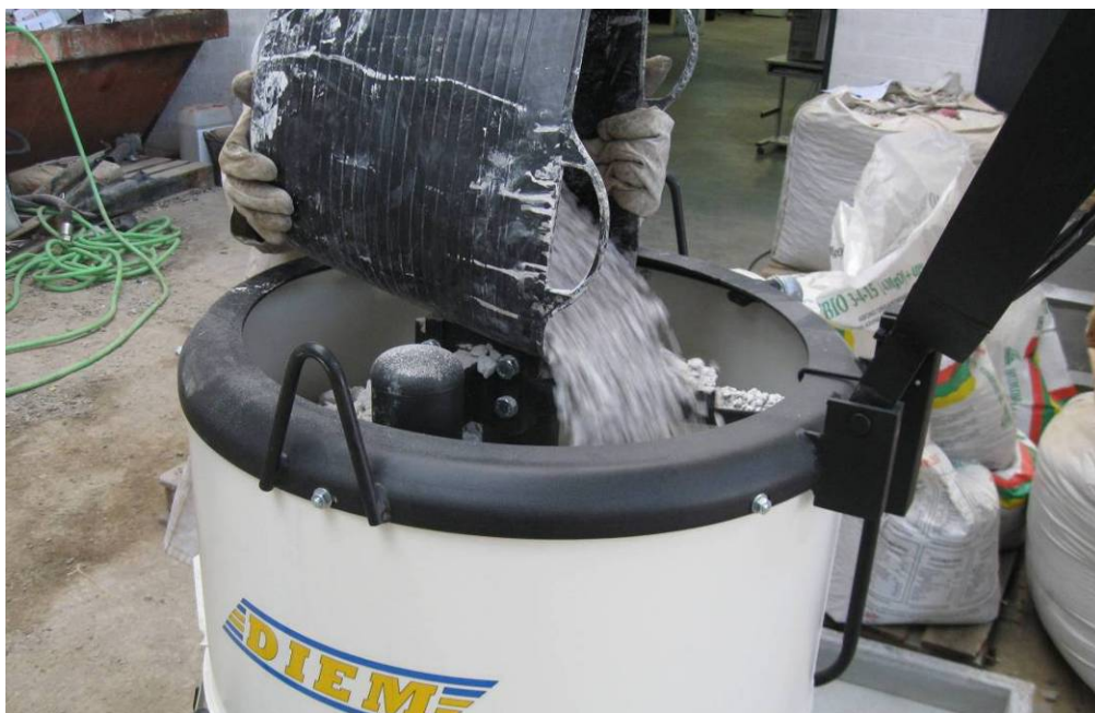
Fig. 49. Incorporación de los áridos gruesos en la hormigonera de eje vertical.
