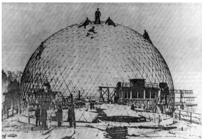
*Fig. 12. Fotografía realizada durante la construcción de la Cúpula de Jena del año 1922.*
