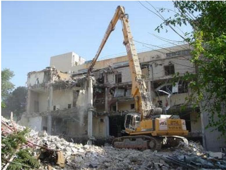
Fig. 8. *Proceso de demolición de una estructura de hormigón.*
