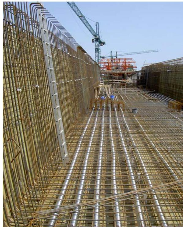
*Fig. 11. Detalle del montaje y distribución de las armaduras de acero antes de su recubrimiento mediante hormigón. El entramado de barras de acero aumentará considerablemente la resistencia a tracción y cortante del hormigón que será utilizado en la construcción.*
