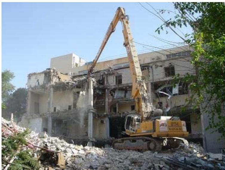
*Fig. 2. Demolición selectiva en la que, primero, se elimina la tabiquería y otros componentes para, finalmente, demoler la estructura de hormigón.*
